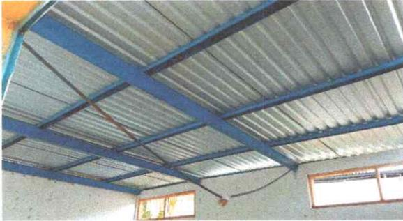
Foto 1: Se observa la colocación de lamina troquelada que concluyo los trabajos.
