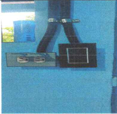
Foto 7 : Se observa la sustitucion el sistema electrico.
