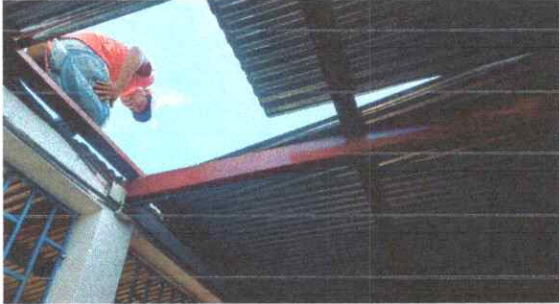
Foto 1: Se observa la colocación de lamina troquelada.
