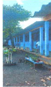
Foto 08: Se observa que se le estan dando el mantenimiento adecuado columnas y soleras
