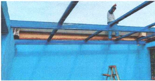
Foto 9: Se observa que se esta aplicando pintura a muros exteriores.
