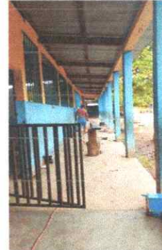
Foto 4: Se observa que los trabajos de cambio de balcones se esta realizando.
