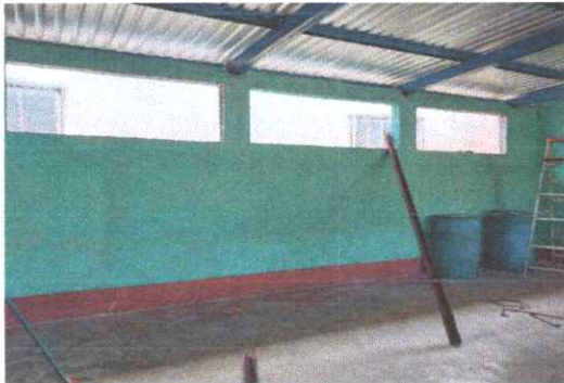
Foto 3: Se observa que los trabajos en aula, el area de ventilacion e iluminacion se hicieron.
