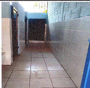
FOTO 3: SE OBSERVA LA FINALIZACIÓN DE PEGADO DEL AZULEJO EN SERVICIOS SANITARIOS, DEBIDO QUE HUBO CAMBIO DE RENGLÓN SEGÚN CONSTA EN EL ACTA NO. 12-2024.
