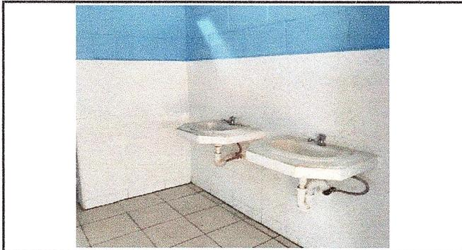
FOTO 15: SE OBSERVA LA FINALIZACIÓN DEL SISTEMA DE MANECILLAS Y MANGUERAS.
