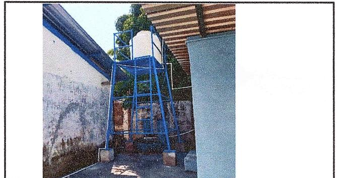
FOTO 10: SE OBSERVA LA FINALIZACIÓN DE LA ELABORACIÓN DE LA BASE DEL ROTOPLAS Y SU TUBERÍA.
