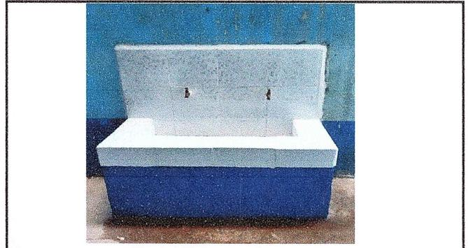
FOTO 8: SE OBSERVA LA FINALIZACIÓN DE CAMBIO DE CHORROS.
