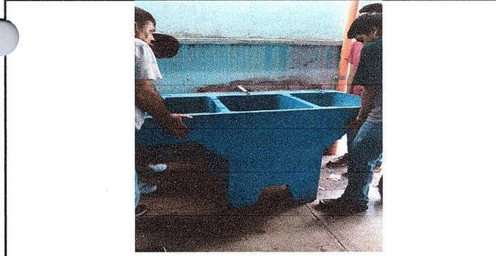
FOTO 17: SE OBSERVA EL PROCESO DE CAMBIO DE PILA.
