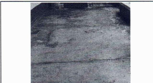
FOTO 4: SE OBSERVA EL PISO RÚSTICO ES NECESARIO COLOCAR PISO ANTIDESLIZANTE.
