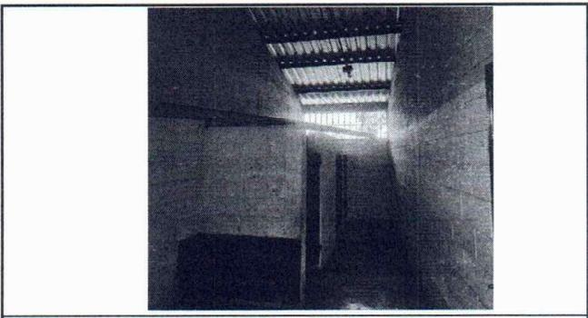
FOTO 12: SE OBSERVA LA PAREDES SUCIAS Y SIN PINTURA.
