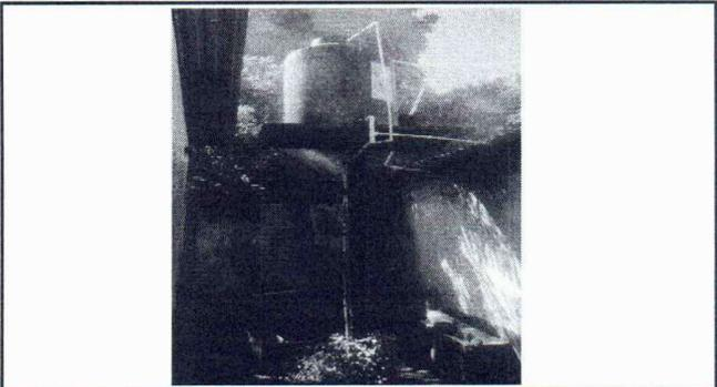
FOTO 10: SE OBSERVA EL DETERIORO DE LA BASE Y EL MAL ESTADO DEL ROTOPLAS COMO DE LA TUBERIA.
