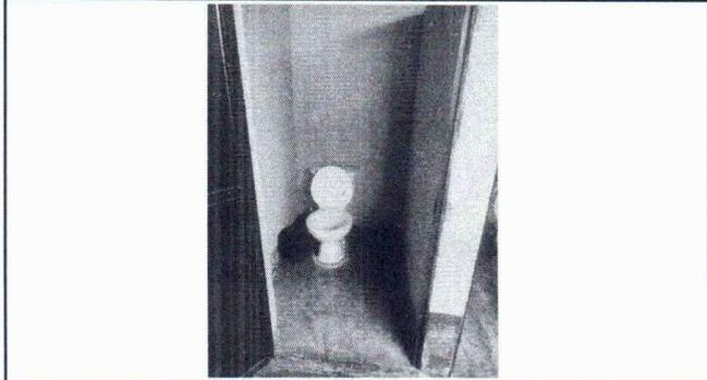
FOTO 7: SE OBSERVA EL MAL ESTADO DE LOS BAÑOS, EL PISO ES RÚSTICO, URGE PISO ANTIDESLIZANTE Y LA PAREDES SUCIAS Y SIN AZULEJO.
