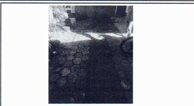
FOTO 2: SE OBSERVA ADOQUINES AL INGRESAR AL CENTRO EDUCATIVO, ES NECESARIO UNA PLANCHA DE CONCRETO.
