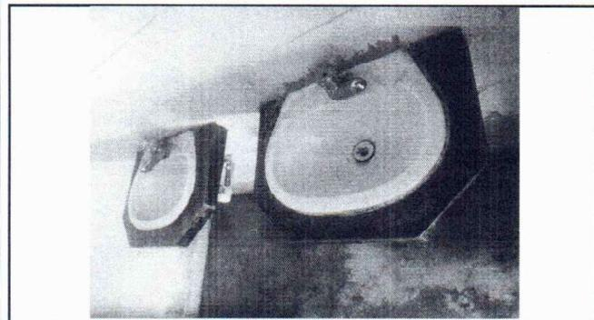
FOTO 15: SE OBSERVA QUE NO FUNCIONA EL SISTEMA DE MANECILLAS Y MANGUERAS, URGE CAMBIARLO.
