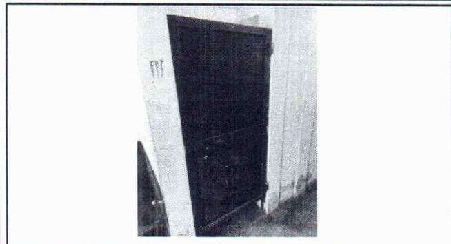
FOTO 13: SE OBSERVA EL ÓXIDO Y FALTA DE PINTURA EN LAS PUERTAS, URGE DARLE MANTENIMIENTO.
