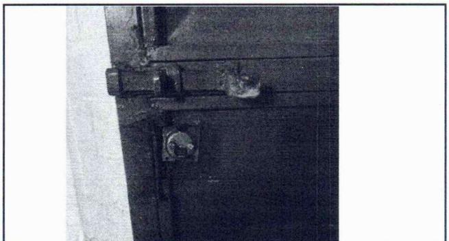
FOTO 16: SE OBSERVA EL MAL ESTADO DE LAS CHAPAS DE LA PUERTA.
