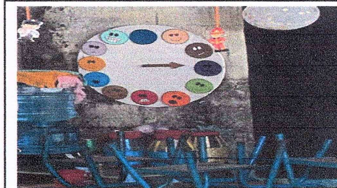
Foto 10: Se observa la necesidad de reparación de muros
