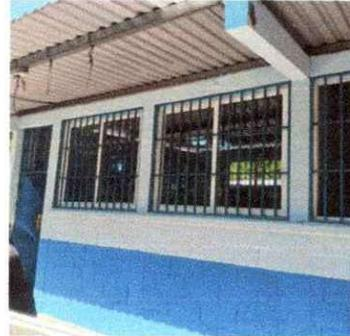
Foto 8. Se observa las ventanas corredizas de PVC pre fabricadas debidamente instaladas y terminadas.
