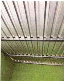
Foto 3. Se observa la lamina y la estructura del techo de la cocina terminando.
