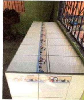
Foto 4. Se observa el suministro e instalación del Azulejo de la mesa de cocina debidamente terminado.
