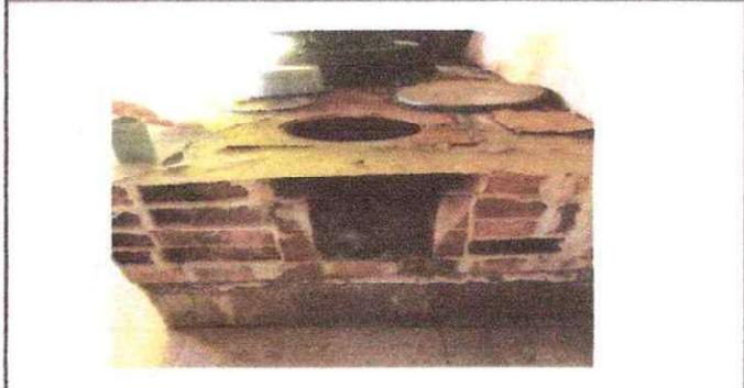
Foto 2: Se observa que la estufa rural no cuenta con puertas o tapadera para evitar la salida de humo
