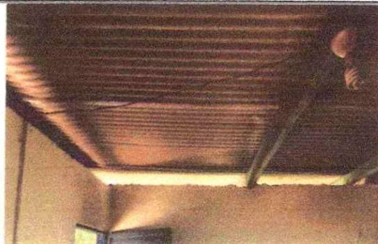
Foto 8: Se observa la necesidad de darle mantenimiento a la estructura de soporte de metal
