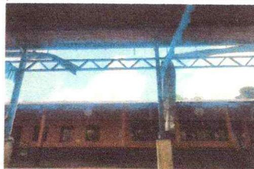
Foto 12: Se observa el deterioro de el canal y bajadas de agua pluvial de la cancha polidportiva
