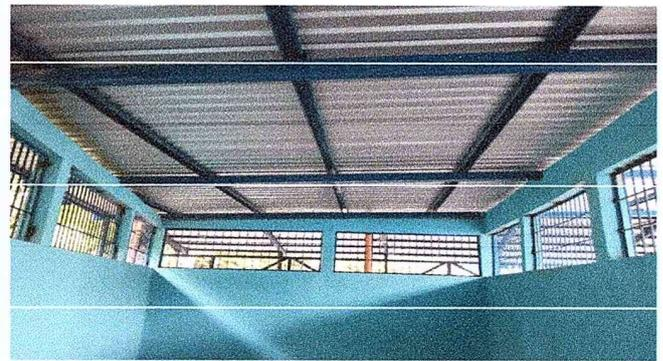
Foto 2: Se observa que se cambió de la estructura de soporte de madera por metal.
