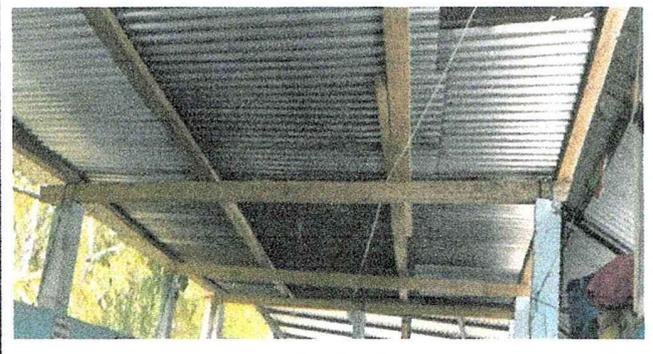
Foto 2: Se observa que se necesita realizar el cambio de la estructura de soporte de madera por metal.
