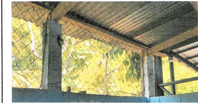
Foto 1: Se observa que el módulo de aulas necesita sustitución de laminas.
