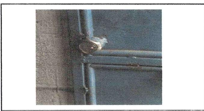
FOTO 6: SE OBSERVA QUE SE NECESITA CAMBIO DE CHAPA
