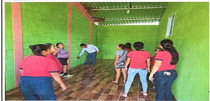
Foto 6: SE OBSERVA QUE LOS MUROS INTERNOS NECESITAN RESANE Y APLICACIÓN DE PINTURA LÁTEX ACRÍLICA
