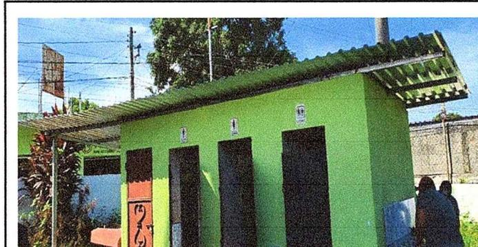
Foto 16: SE OBSERVA QUE FUE CAMBIADA LA CUBIERTA EN LOS SERVICIOS SANITARIOS.
