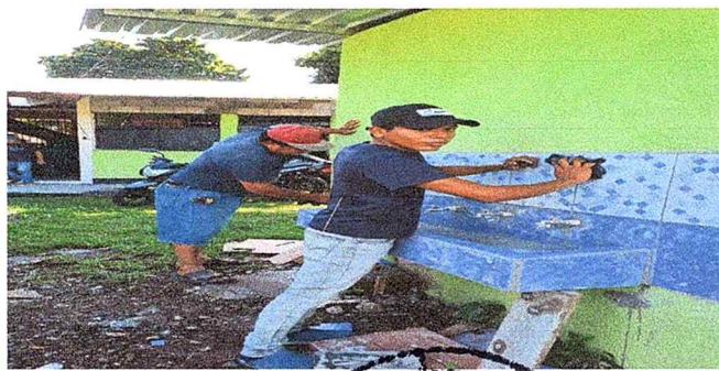
Foto 11: SE OBSERVA QUE SE ESTÁ TRABAJANDO LA ESTACIÓN DE LAVADO.
