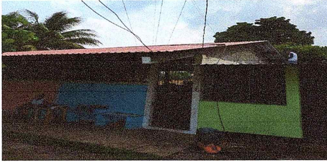
Foto 1: SE OBSERVA QUE SE ESTA TRABAJANDO LOS MÓDULOS 1 Y 2 DE AULAS A REMOZAR.
