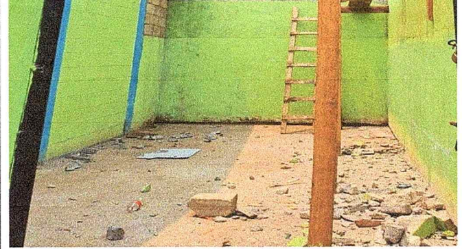
Foto 8: SE OBSERVA QUE ESTAN TRABAJANDO EL CONCRETO RUSTICO
