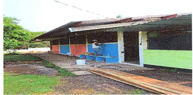
Foto 2: SE OBSERVA QUE SE ESTA DANDO MANTENIMIENTO PREVENTIVO A BALCONES.
