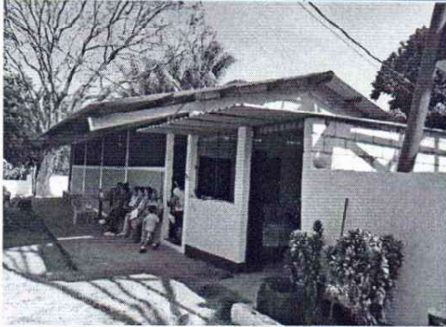
Foto 1: Se observan los módulos 1 y 2 de aulas a remozar
