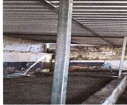
Foto 8: Se observa que ya cuenta con la torta de concreto.
