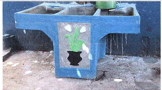
Foto 10: Se observa que la pila ya fue sustituida.
