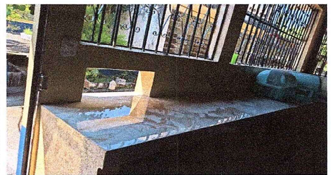
Foto 4: Se observa que el banco de trabajo ya fue instalado.
