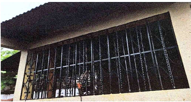
Foto 3: Se observa que los balcones ya fueron sustituidos
