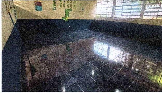
Foto 7: Se observa que el piso ya fue sustituido-
