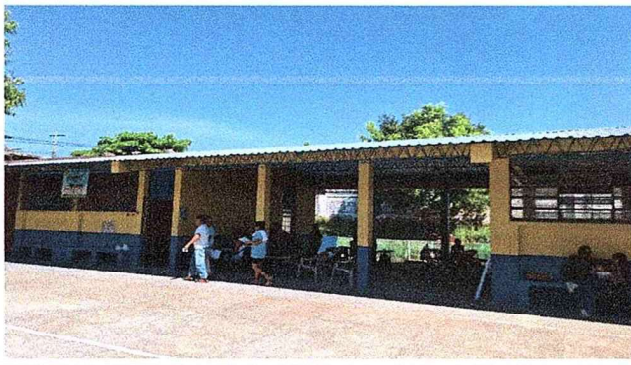
Foto 1: Se observa que la lámina ya fue sustituida.
