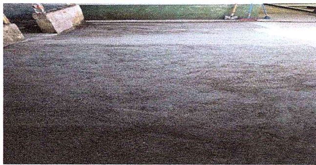
Foto 9: Se observa plancha de concreto finalizada.
