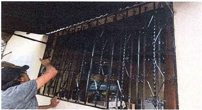
Foto 3: Se observa que están trabajando en los balcones.
