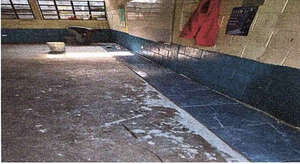
Foto 7: Se observa que ya están pegando piso cerámico.
