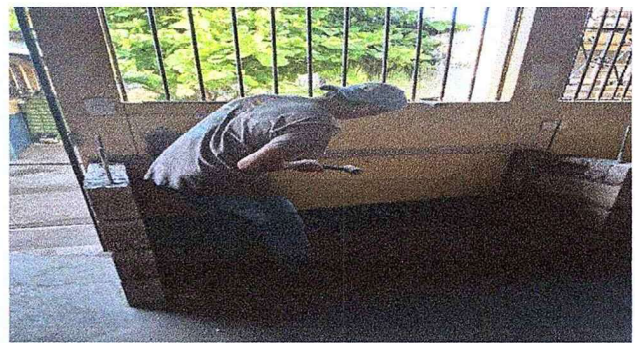
Foto 4: Se observa que están realizando el banco de trabajo
