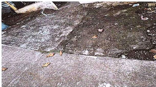
Foto 9: Se observa que la plancha de concreto se encuentra en mal estado.
