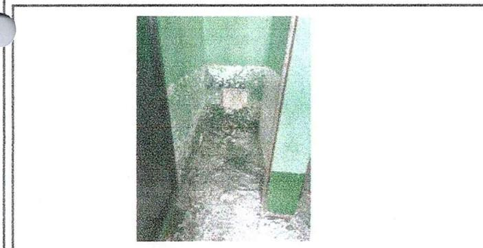
Foto 5: Se observan paredes trabajadas para instalación de azulejo
