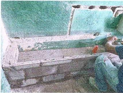
Foto 9: Se observa mingitorio en proceso de armado
