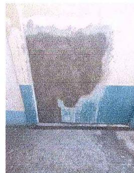
Foto 16: Se observa reparación de repello en pared
