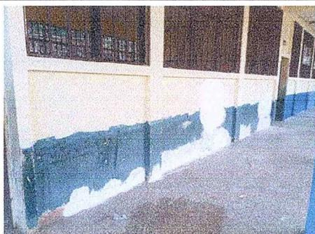
Foto 17: Se observa pared en reparación de cernido
