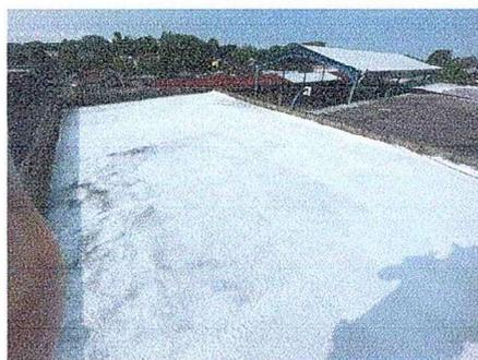
Foto 18: se observa trabajos de impermeabilizado de losa
