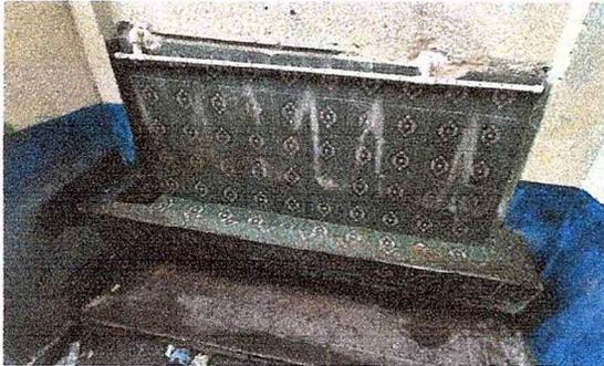
Foto 9: Se observa mingitorio de concreto y azulejo en mal estado
