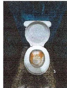
Foto 4: Se observan inodoros, manchados, con falta de accesorios y problemas de funcionamiento
