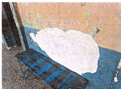
Foto 17: Se observa pared con cernido dañado
