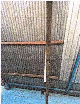
Foto 11: Se observa lámina vieja acanalada en uso y con partes oxidadas
