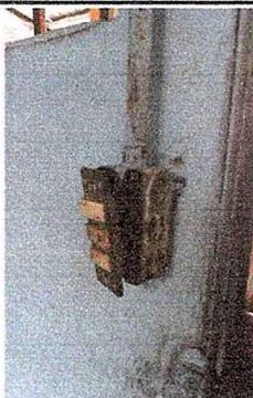
Foto 15: Se observa sistema eléctrico con deficiencias, tomacorrientes sin energía, falta de funcionamiento de los apagadores y faltante de luminarias.
