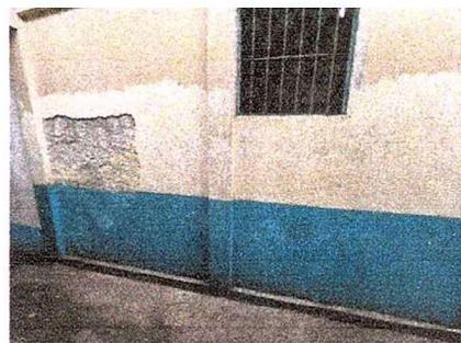
Foto 16: Se observa pared dañada en el repello.
