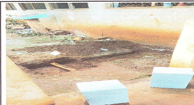
Foto 9: Se observa el proceso en la instalación de la pila.
