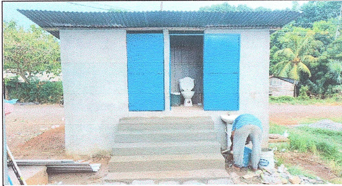
Foto 1: Se observa el único módulo de servicios sanitarios en el proceso de remozamiento.
