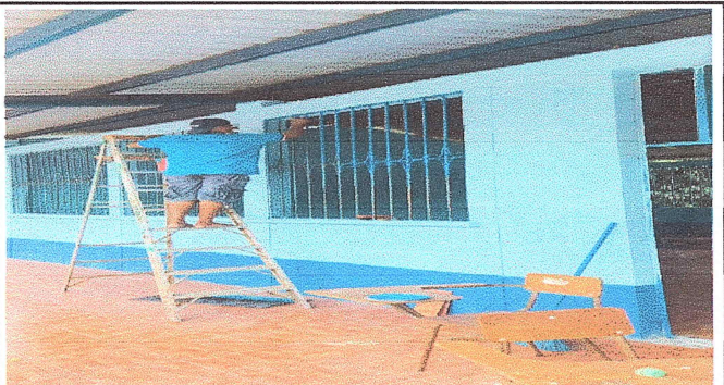
Foto 12: Se observa el mantenimiento de los balcones metalicos de las aulas del módulo 2.
