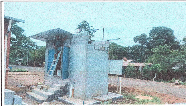
Foto 4: Se observa la colocación de la ventana.
