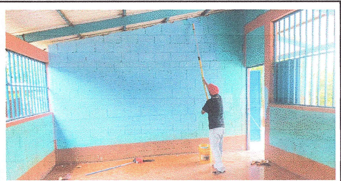
Foto 10: Se observa el proceso de los módulos de aulas 1 y 2.
