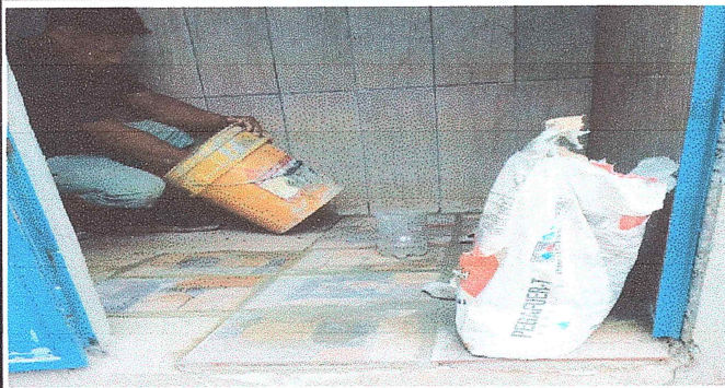
Foto 7: Se observa el área del piso del baño en remozamiento.
