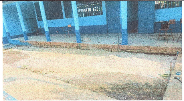
Foto 8: Se observa en proceso de remozamiento en el pavimento de concreto.
