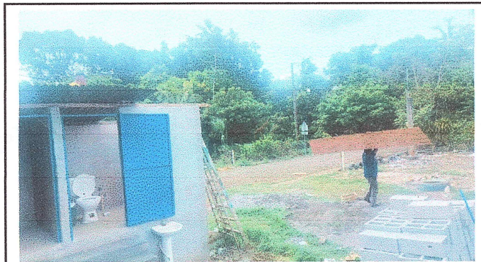
Foto 3: Se observa el cambio de lámina y estructura metálica.
