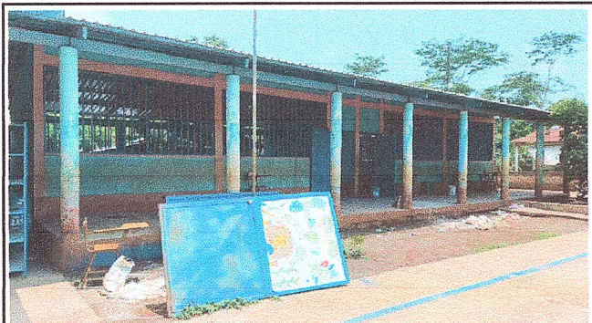
Foto 11: Se observa en el remozamiento de la puerta del módulo de aula 2.
