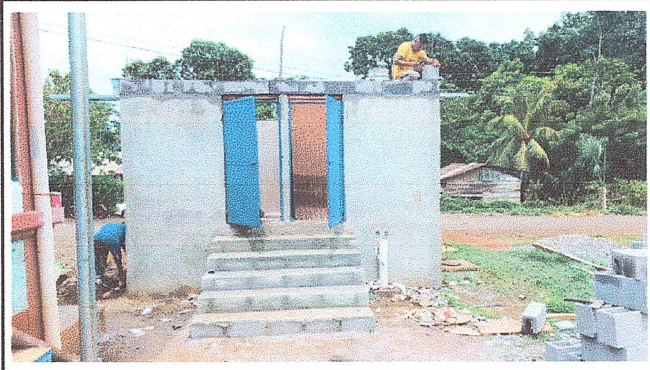
Foto 2: Se observa el cambio de lámina y la colocación de filas de block.
