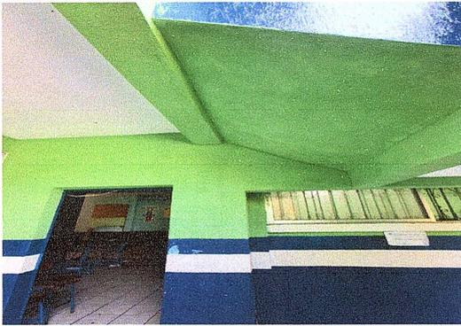
Foto 9: Se observa el proceso de humedad y desprendimiento de repello en el módulo de gradas
