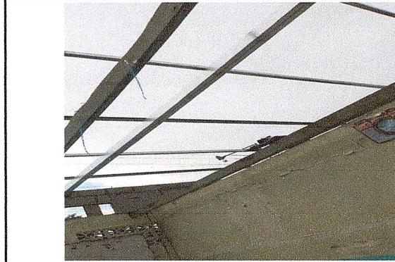
Foto 2: Se observa el proceso que módulo de aulas 1 tiene la lámina y estructura de metal en mal estado, urge su sustitución. Además es necesario sustituir el sistema eléctrico, el cual se dañará al desmontar la
