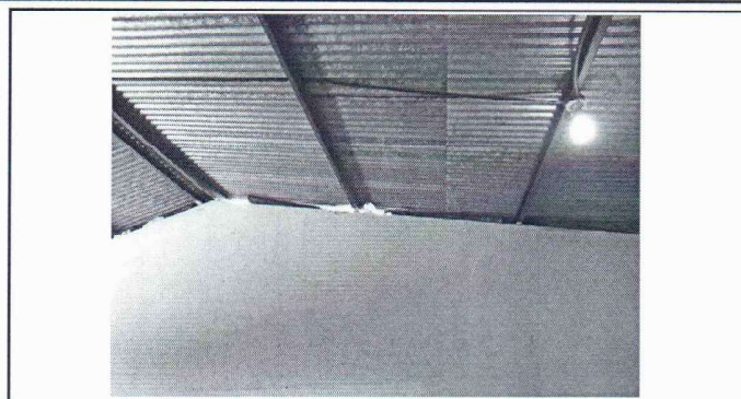
Foto 8: Se observa que el agua de lluvia que se filtra por el mojinete, está afectando los muros.
