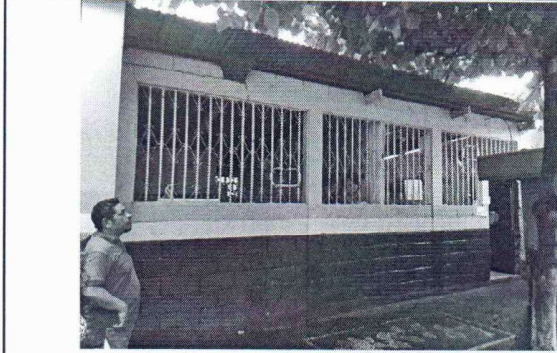
Foto 1: Se observa el módulo de aulas 1 a remozar en techo, muros, ventanas, piso y puertas
