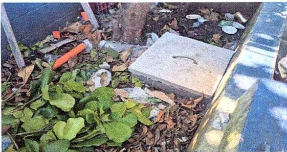
Foto 17: Se observa que la caja de registro está terminado así como la instalación de tubería para aguas negras.
