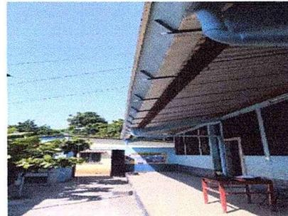
Foto 12: Se observa la colocación y finalización de los trabajos en los canales de cada uno de los módulos.
