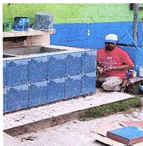
Foto 17: Se observa la instalación de la caja de registro e instalación tubería para drenaje de aguas negras.
