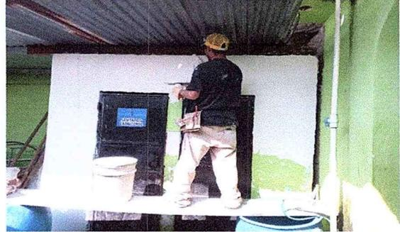
Foto 20: Se observa la primera mano de pintura en las paredes que necesitan ser pintadas.
