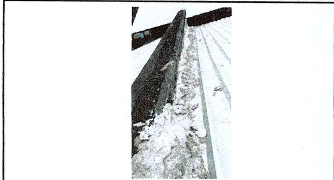
Foto 13: Se observa filtración en uniones de techo y pared.
