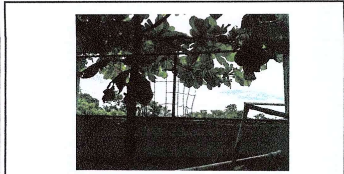
Foto 19: Se observa que la cerca perimetral se encuentra en mal estado.
