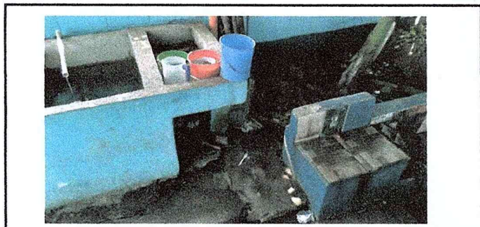
Foto 17: Se observa pila sin caja de registro ni drenaje de aguas negras.
