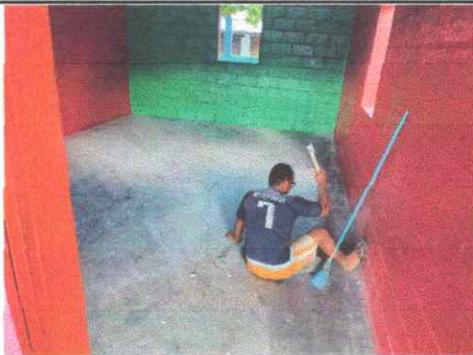
Foto 5: Picando el cemento para poder pegar el piso
