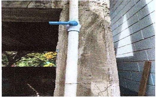
Foto 16: Se observa de la finalizacion de reparacion de la tubería principal de agua potable.
