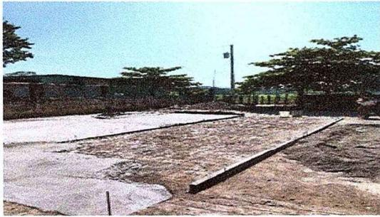
Foto 13: Se observa el proceso de aplicación de torta de concreto en patio.
