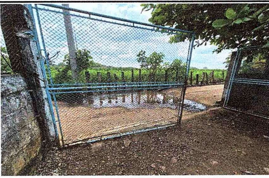
Foto 12: Se observa portón principal de ingreso con soportes dañados, oxidados.
