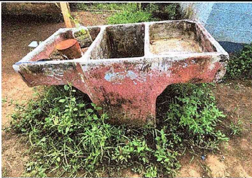
Foto 5: Se observa pila de cemento dañada y no funcional
