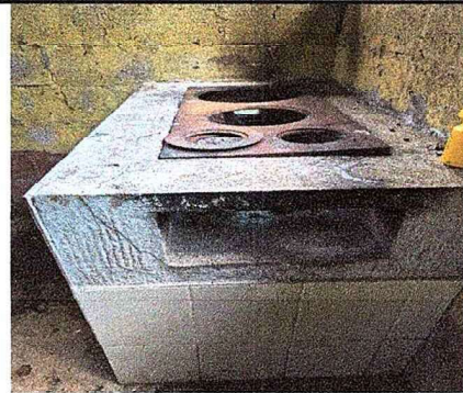
Foto 6: Se observa estufa con estructura rajada, sin ladrillo en cámara y deteriorada y azulejo despegado
