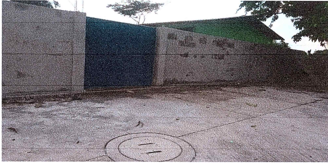
Foto 1: suministro e instalacion de muro de block terminado.
