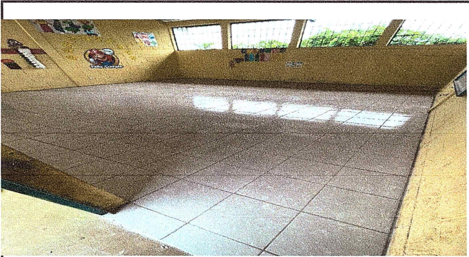
Foto 9: suministro de piso ceramico terminado
