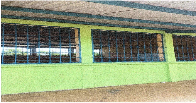
Foto 7: mantenimiento de balcones de metal finalizado .
