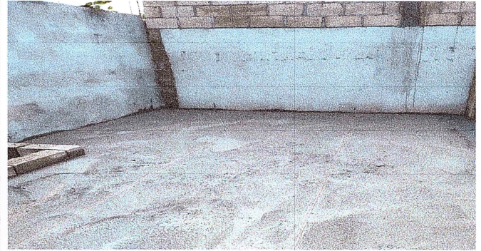
Foto 8: Suministro de plancha de concreto para patio finalizado.
