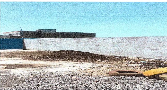
Foto 3: repello de muro finalizado.
