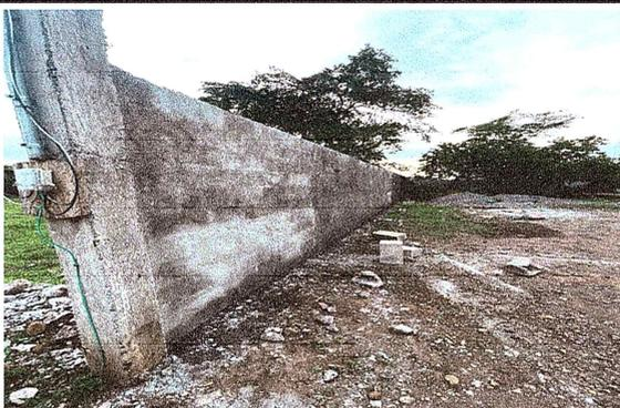
Foto 3: repello en muro en proceso
