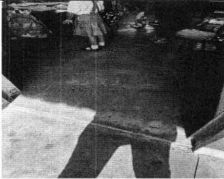
Foto 9: Las aulas solamente tienen una torta alisada, se le colocará piso cerámico.
