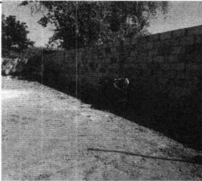
Foto 3: El muro perimetral del lado derecho no cuenta con repello, se prioriza hacer el repello en dicha pared.
