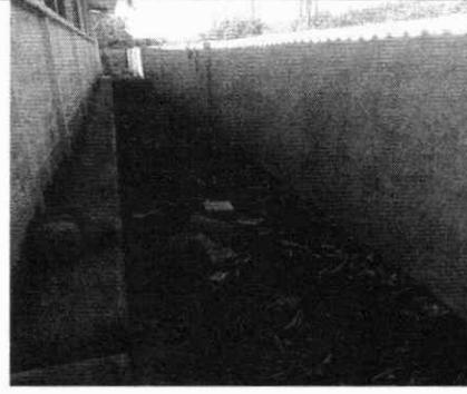
Foto 2: El muro perimetral de la parte trasera esta bajo, por lo que necesita aumentar la altura, se considera que es necesario agregar 2 hiladas de block más.
