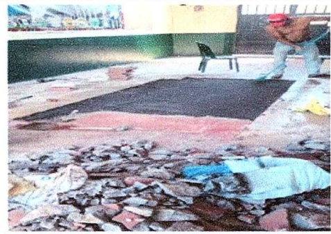
FOTO 6: LEVANTAMIENTO DE PISO
