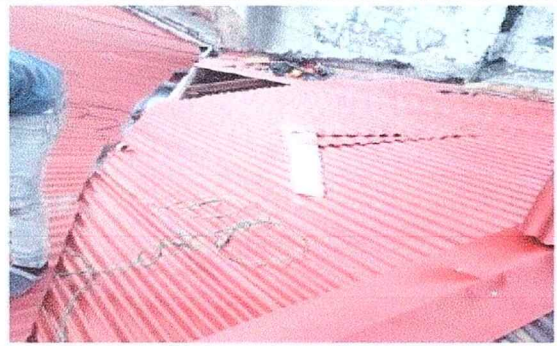
FOTO 4: SE PARECIA LA COLOCACION DE LA LAMINA CON SU CAPOTE
