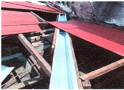
FOTO 3: SE REALIZO LA SUSTITUCION DE CANALES DE AGUA
