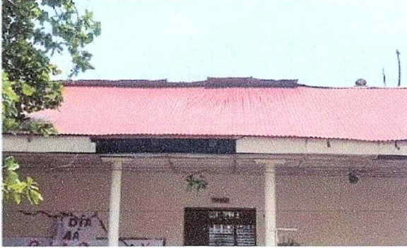
FOTO 1: SE OBSERVAN LAS LAMINAS NUEVAS DISPUESTAS PARA SU COLOCACION
