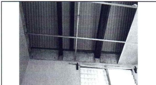
Foto 2: Se observa que la estructura de madera se encuentra en mal estado urge la sustitución del mismo.
