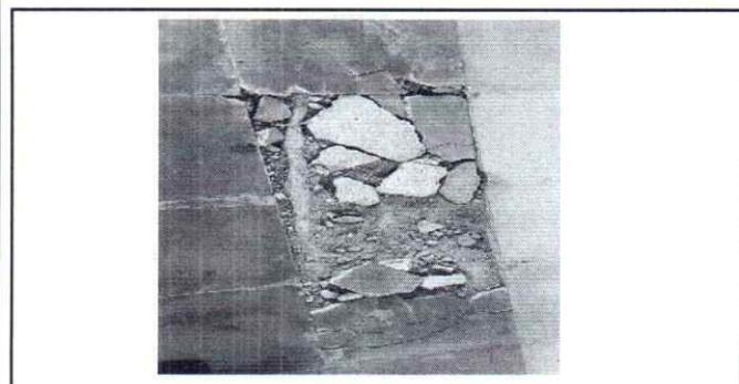
Foto 5: Se observa hundimiento en un área, es necesario sustituir la base de concreto que se encuentra en mal estado.
