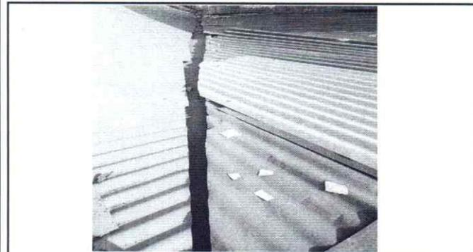
FOTO NO.1 . Se observa que la lamina esta en mal estado tiene filtracion de agua, urge la sustitucion.
