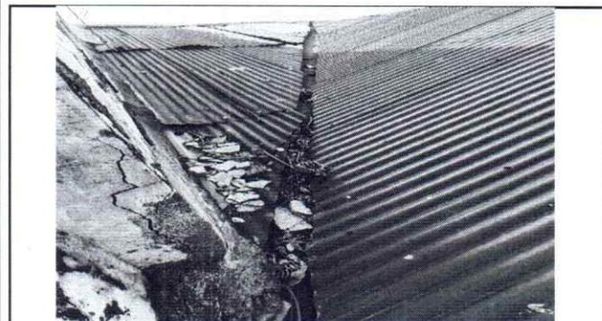
Foto 3: Se observa que que el canal de autocaudal tiene daños por falta de mantenimiento tiene filtracion de agua el cual daña la pared e inunda la aulas donde reciben clases los niños, es urgente el cambio
