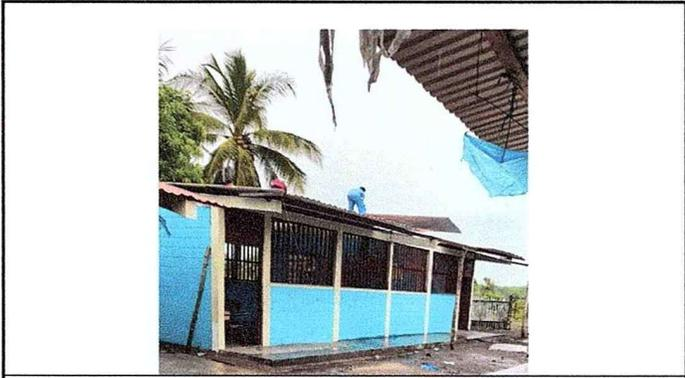
Foto 1: se observa que se inició con los trabajos para realizar la sustitución de la lámina,
