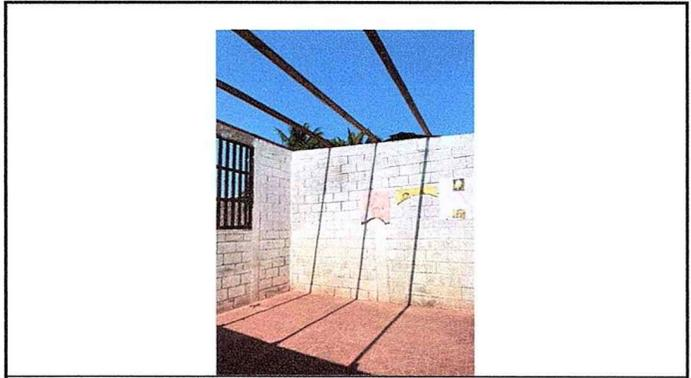
Foto 2: Se observa que ya se realizó el cambio de la estructura de soporte de madera.
