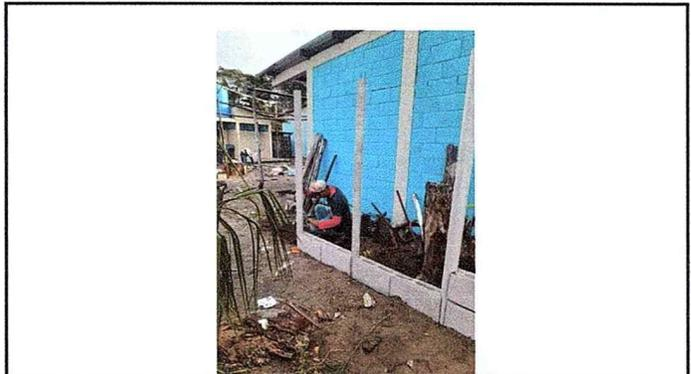
Foto 4: se inició con los trabajos para la colocación del muro perimetral prefabricado.
