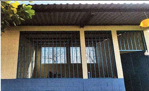
FOTO 3: SE OBSERVA LA FINALIZACIÓN DE MANTENIMIENTO DE BALCONES.
