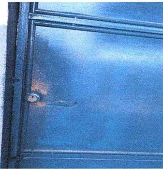
FOTO 5: SE OBSERVA LA FINALIZACIÓN DE CAMBIO DE CHAPA.
