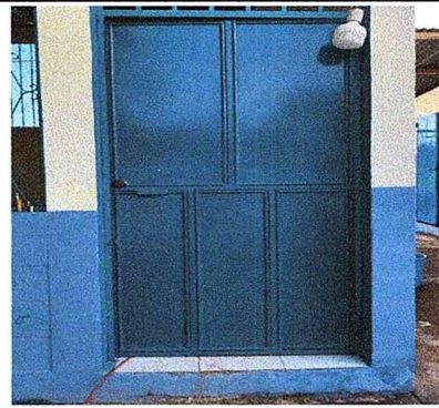
FOTO 4: SE OBSERVA LA FINALIZACIÓN DE MANTENIMIENTO DE PUERTA.
