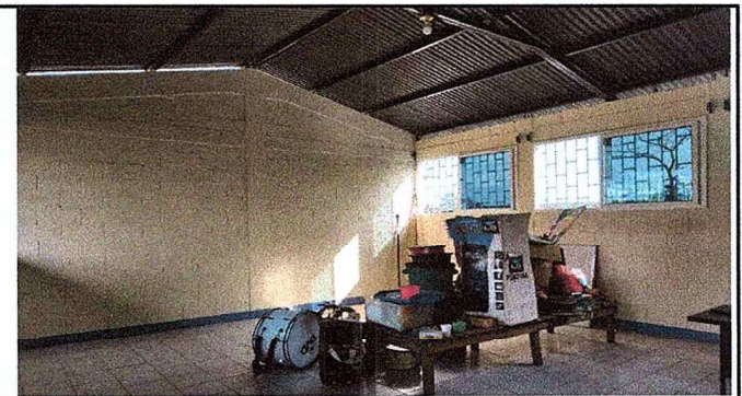
FOTO 6: SE OBSERVA LA FINALIZACIÓN DE PINTADO DE PAREDES.
