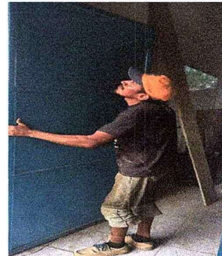
FOTO 4: SE OBSERVA EL PROCESO DE MANTENIMIENTO DE PUERTA.
