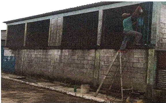
FOTO 3: SE OBSERVA EL PROCESO DE MANTENIMIENTO DE BALCONES.
