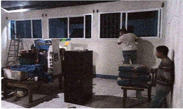
FOTO 1: SE OBSERVA EL PROCESO DE INSTALACIÓN DE VENTANAS DE PVC.
