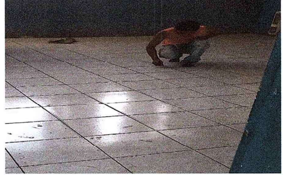
FOTO 2: SE OBSERVA EL PROCESO DE INSTALACIÓN DE PISO CERÁMICO.
