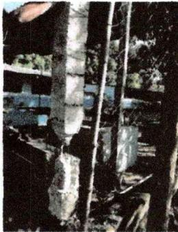
Foto 3: Se Observa el proceso de reparación de las culumnas de muro.
