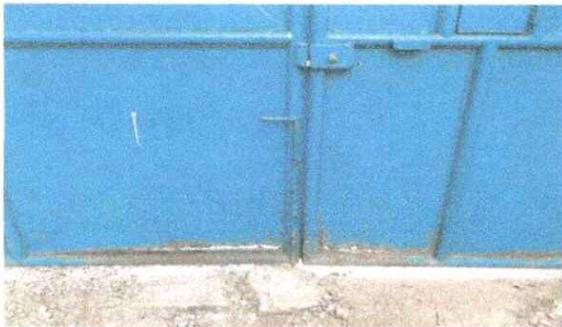
Foto 5: Se observa la necesidad de darle mantenimiento al porton debido al deterior por corrosion
