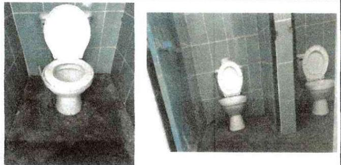
Foto 6: Se Observa la necesidad de cambio de los inodoro debido a la filtracion
