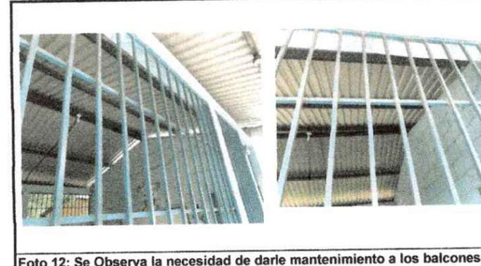
Foto 12: Se Observa la necesidad de darle mantenimiento a los balcones de metal
