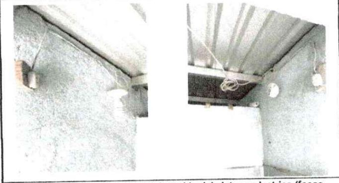
Foto 8: Se observa la necesidad del cambio del sistema electrico (focos, apagadores, plafoneras y tomacorrientes)
