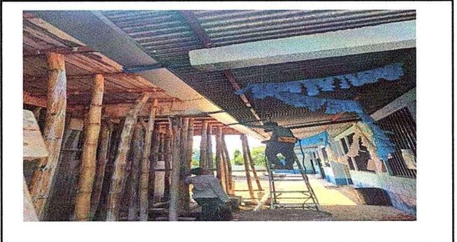
Foto 2: Se observa el avance de la instalación de canal de metal.
