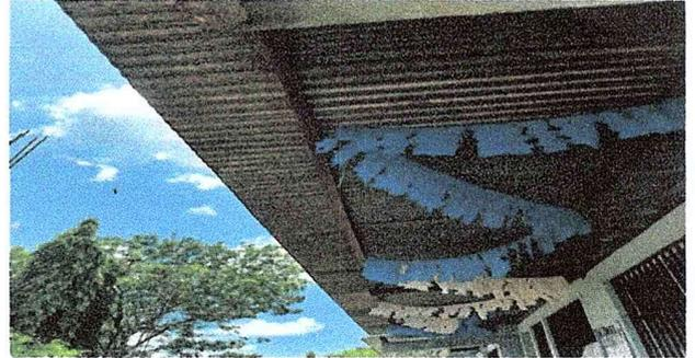
Foto 2: Se observa que no se cuenta con canal para la bajada de agua.
