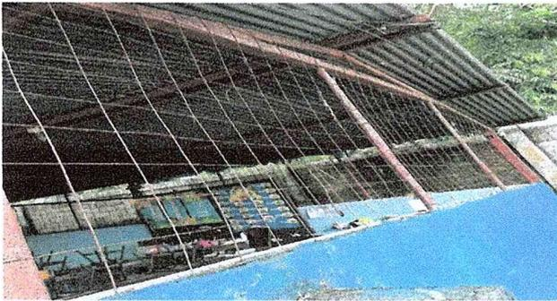
Foto 3: Se observa que la electromalla está en mal estado, se sustituirá por balcones de metal.
