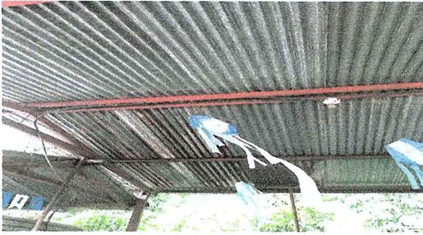
Foto 1: Se observa la lámina en mal estado.
