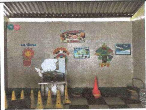
Foto 1: se observa que se necesita abrir unas ventanas para iluminación y ventilación, colocar balcones y resanar paredes con pintura
