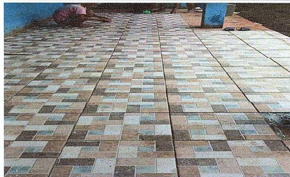
Foto 6: Se observa el proceso colocación de piso ceramico
