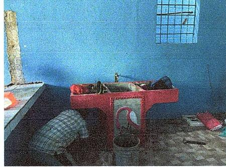
Foto 14: Se observa el proceso de instalación de tubería para agua potable de la pila
