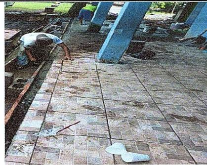
Foto 24: Se observa el proceso de piso cerámico
