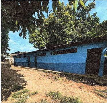
Foto 7: Se observa que el caminamiento se encuentra en mal estado y húmedo en algunas áreas y el espacio es muy reducido
