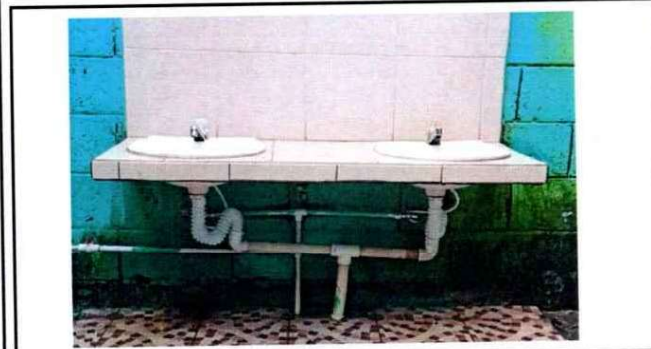
Foto 15: El trabajo de mantenimiento de desagüe y llaves de paso en los dos lavamanos culminado.
