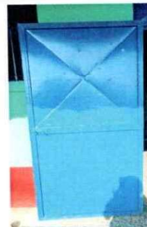
Foto 12: Mantenimiento de puertas culminado.
