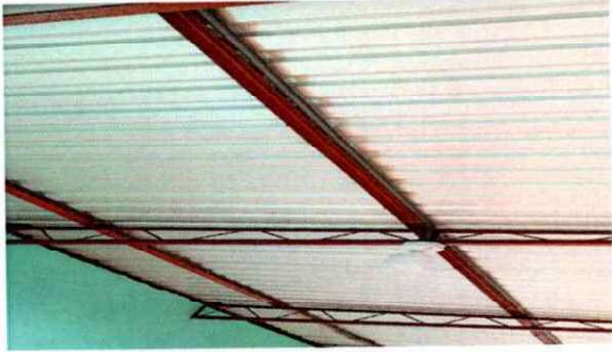
Foto 7: Mantenimiento de la estructura de metal del corredor terminada.
