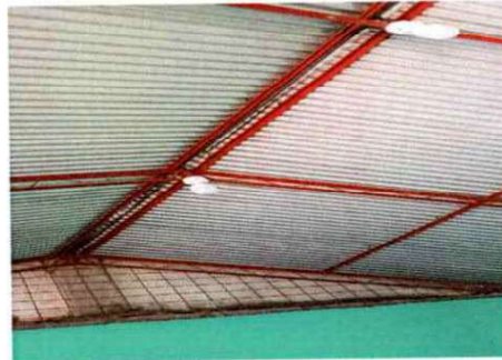
Foto 10: Se concluyó con el suministro de energía eléctrica en las aulas y corredor.
