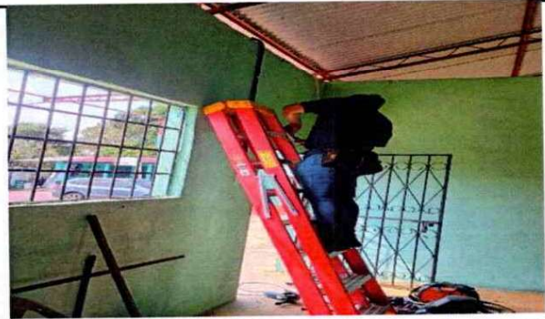
Foto 10: En las aulas se está suministrando la energía eléctrica e instalando focos y tomacorrientes.
