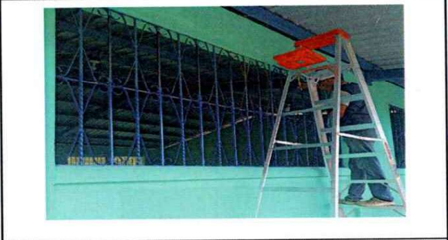
Foto 2: Dándole mantenimiento a los balcones de las aulas del segundo nivel.
