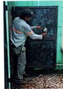
Foto 14: a las puertas de los baños se les está dando el mantenimiento requerido.
