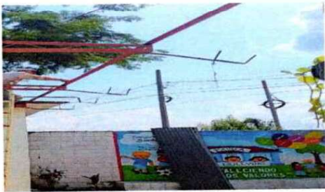
Foto 9: Se ha eliminado por completo el canal antiguo esperando ya en instalar el nuevo.
