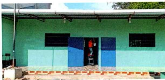
Foto 11: Instalando las puertas de metal en las aulas y dándole los últimos acabados.
