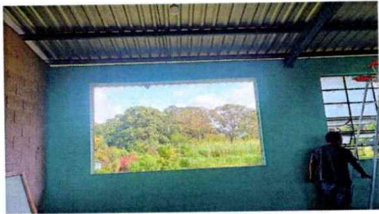
Foto 13: Se está sustituyendo los balcones, de las aulas del segundo nivel, por lo mismo lo están trabajando por dentro por la altura.
