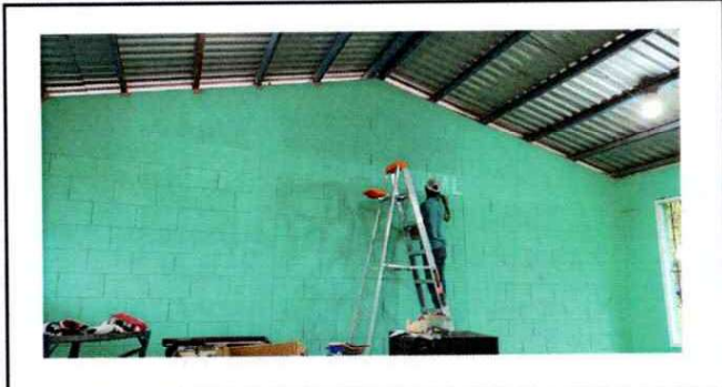
Foto 1: Se observa la nueva pintura aplicándola. Por deterioro en la pintura anterior que tenían las aulas.
