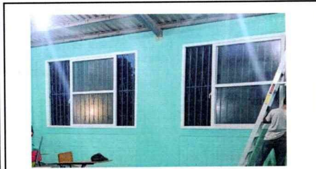
Foto 3: Sustituyendo las ventanas antiguas y ya culminando de instalar ventanas de PVC.
