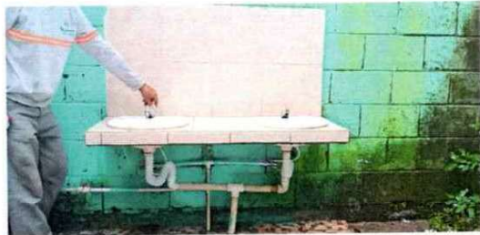
Foto 15: cambio de llaves de paso y en prueba de que todo este quedando en buen estado.
