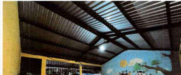
Foto 2: se observa la estructura del techo corroida por el oxido, necesita ser sustituido
