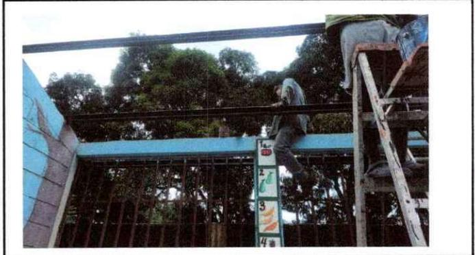
Foto 2: se observa la estructura del techo corroida por el oxido, necesita ser sustituido
