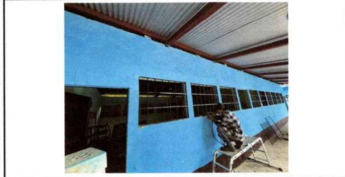
Foto 5: se observan balcones de malla se necesita sustituir e instalar balcones de metal
