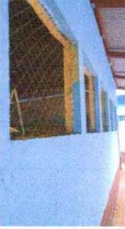
Foto 5: se observan balcones de malla se necesita sustituir e instalar balcones de metal
