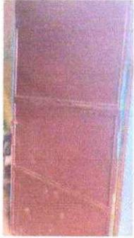
Foto 3: puerta se observa dañada necesita sustituirse
