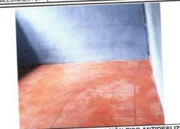
FOTO 7: FINALIZACIÓN DE COLOCACIÓN PISO ANTIDESLIZANTE.
