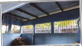
FOTO 8: FINALIZACIÓN DE COLOCACIÓN DE LÁMINAS Y ESTRUCTURA DE SOPORTE DE METAL.
